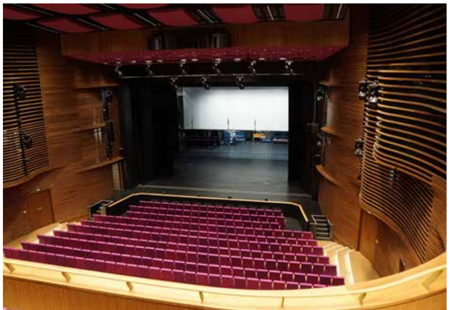
Hinter den Lamellenverkleidungen an den Saalwänden befindet sich ein begehbare Gang, in dem schwere Absorptionsvorhänge verfahren werden können. Foto: BWKI
